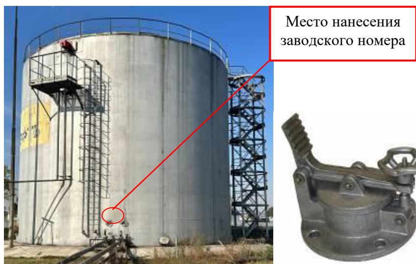
Рисунок 2 – Общий вид резервуара и замерного люка РВС-2000 зав.№ 18
