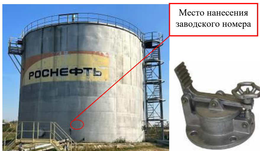
Рисунок 4 – Общий вид резервуара и замерного люка PBC-2000 зав.№ 26
