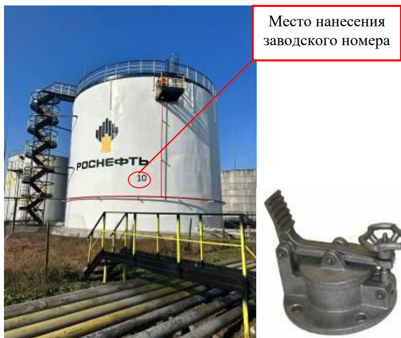
Рисунок 1 – Общий вид резервуара и замерного люка РВС-2000 зав.№ 10
