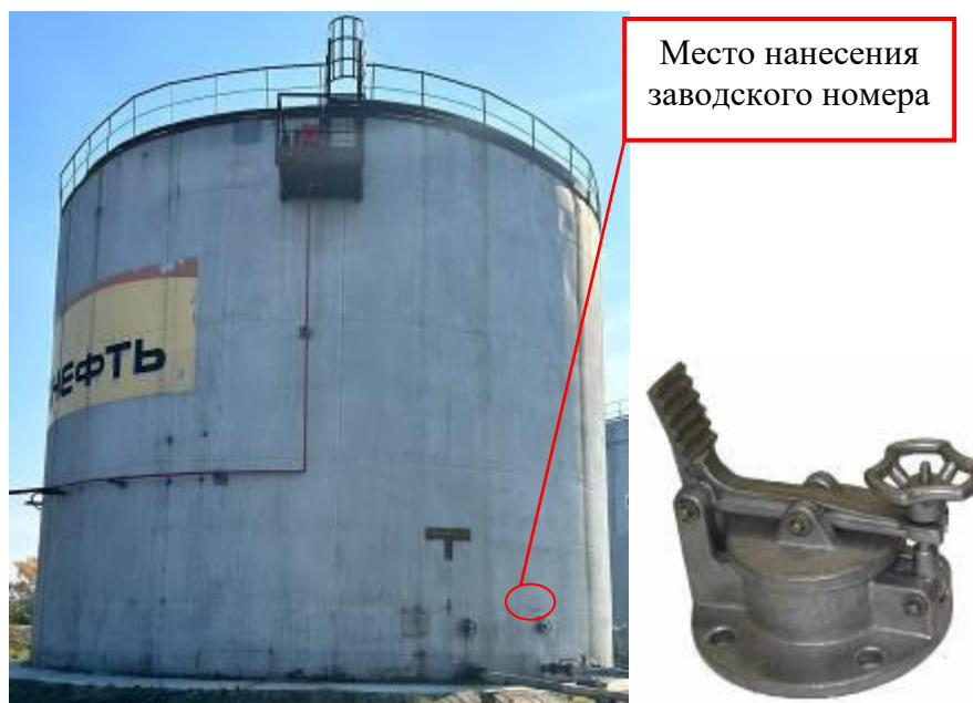
Рисунок 3 – Общий вид резервуара и замерного люка PBC-2000 зав.№ 25
