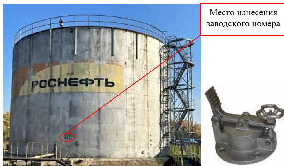
Рисунок 2 – Общий вид резервуара и замерного люка РВС-3000 зав.№ 27
