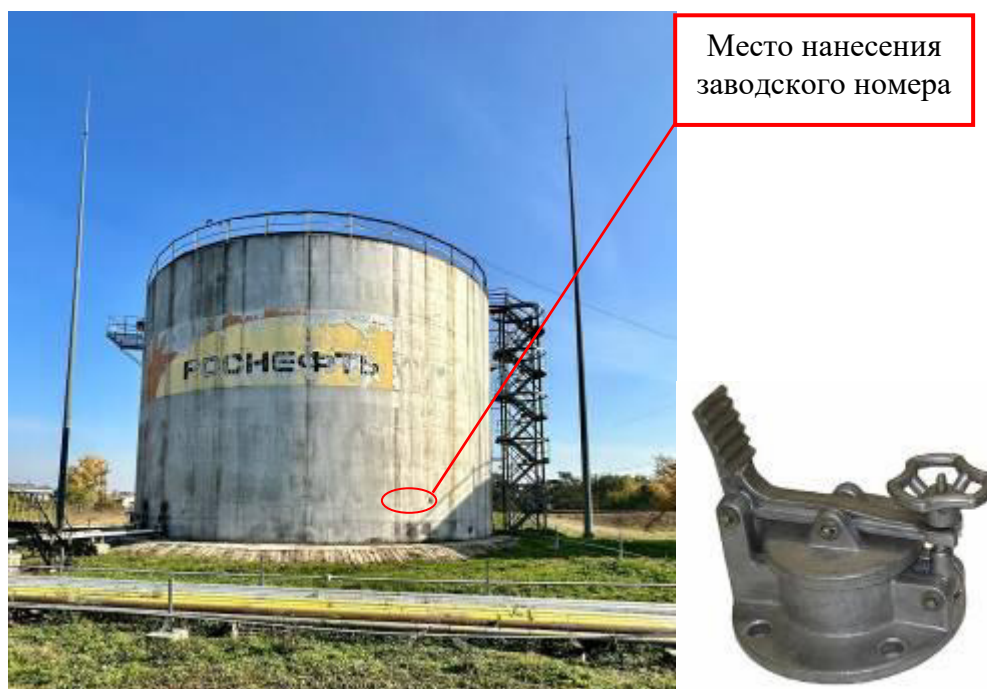
Рисунок 1 – Общий вид резервуара и замерного люка РВС-3000 зав.№ 6
