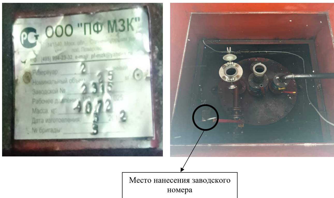
Рисунок 6 – Горловина, замерной люк и заводской номер резервуара РГ-25 зав. № 2315
