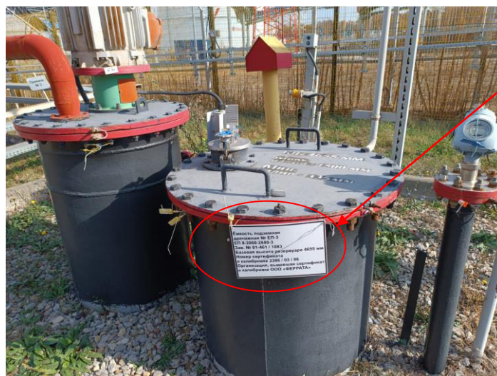
Рисунок 2 – Общий вид заливной горловины ЕП 8-2000-2600-3 зав.№ 01-461/1083
