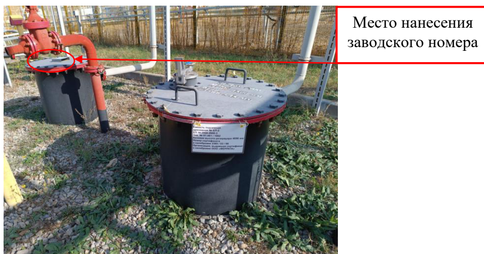
Рисунок 2 – Общий вид резервуара ЕП 16-2000-2600-3 зав.№ 01-461/1082
