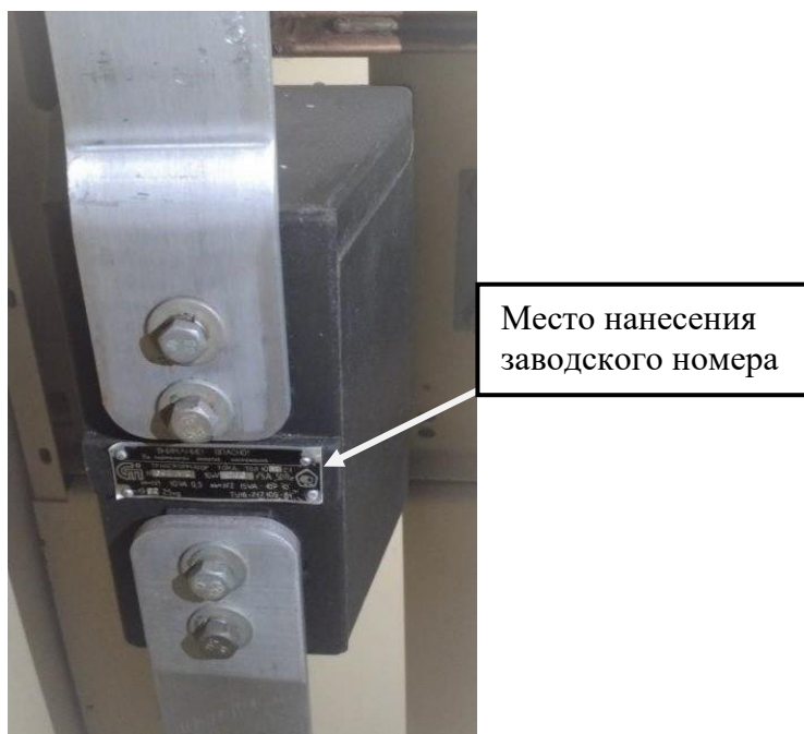
Рисунок 1 - Общий вид трансформаторов тока ТОЛ 10 УТ2.1 с указанием места нанесения заводского номера
