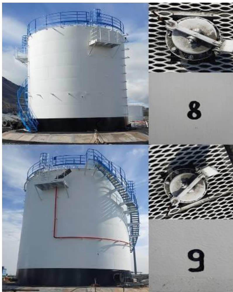
Рисунок 1 – Фотографии общего вида резервуаров стальных вертикальных цилиндрических РВС- 1000, горловин замерных люков и заводских номеров
