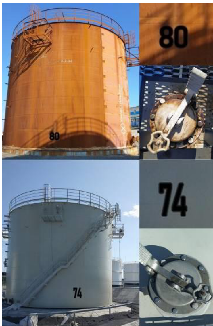
Рисунок 1 – Фотографии общего вида резервуаров стальных вертикальных цилиндрических РВС- 2000, горловин замерных люков и заводских номеров
