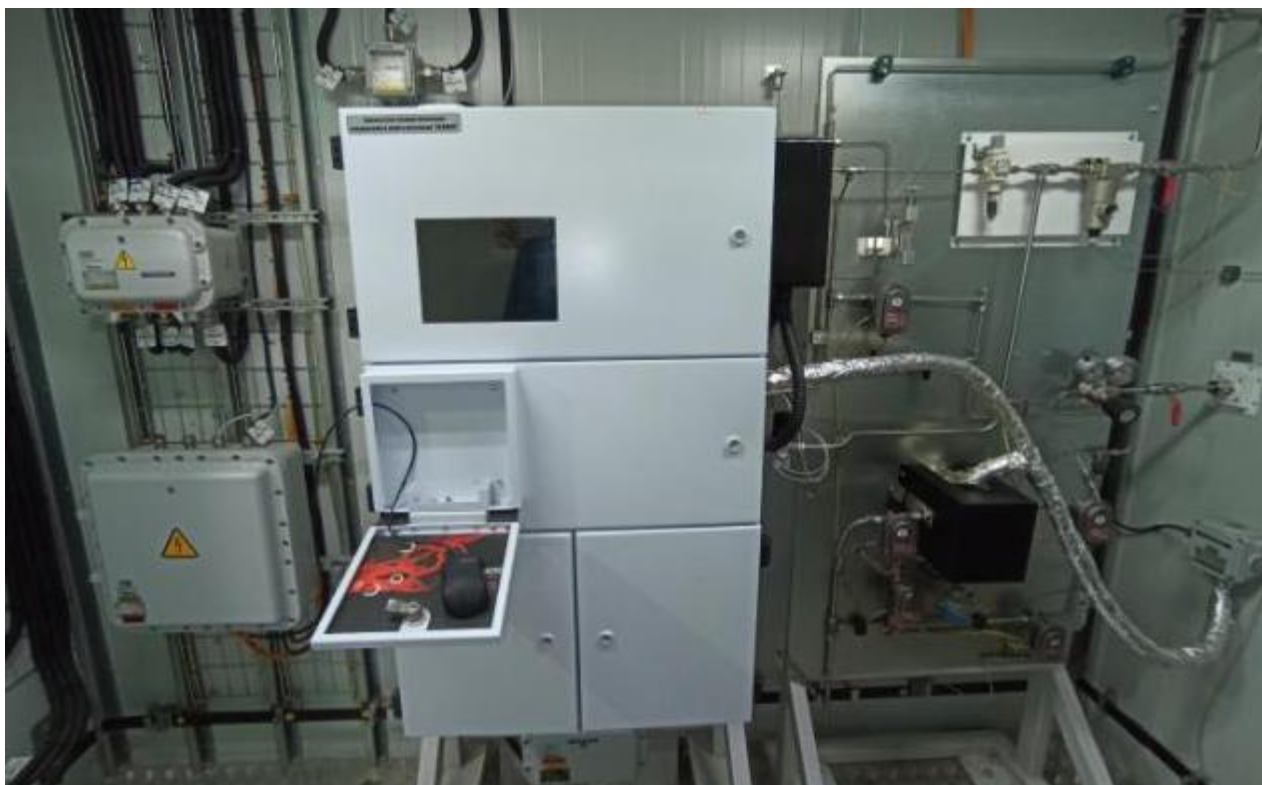
Рисунок 1– Внешний вид анализаторов с блоком подготовки пробы
