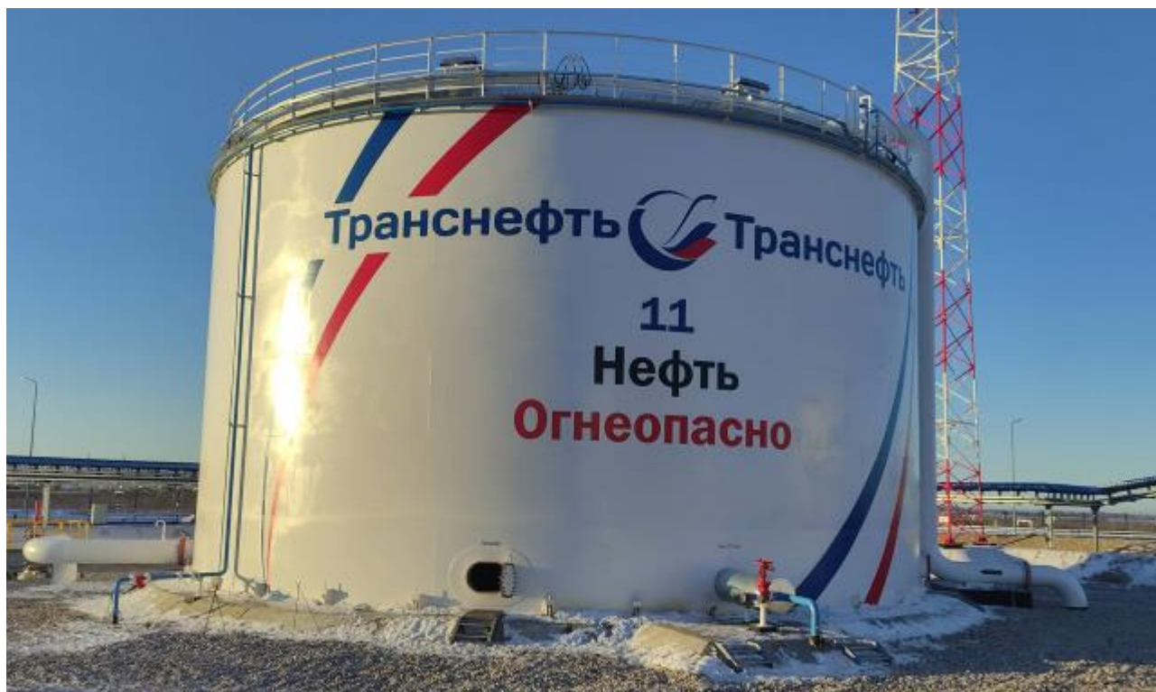
Рисунок 1 – Общий вид резервуара РВС-5000 №11
