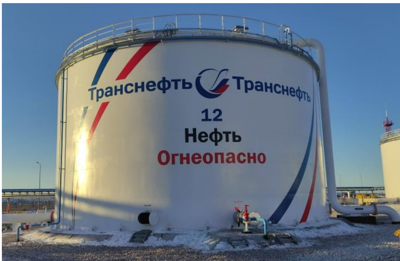
Рисунок 2 – Общий вид резервуара РВС-5000 №12
