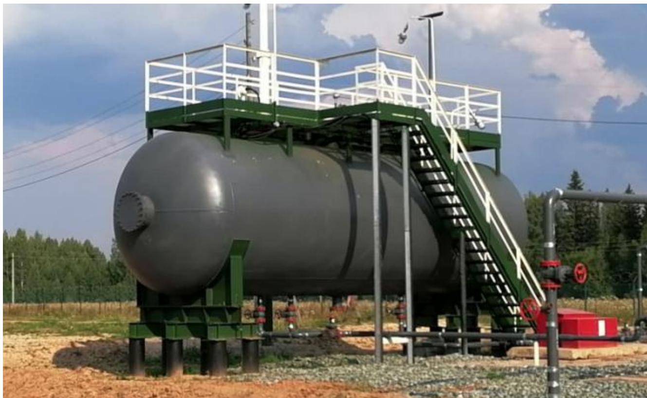
Рисунок 1 - Общий вид резервуара горизонтального стального цилиндрического РГС-85
