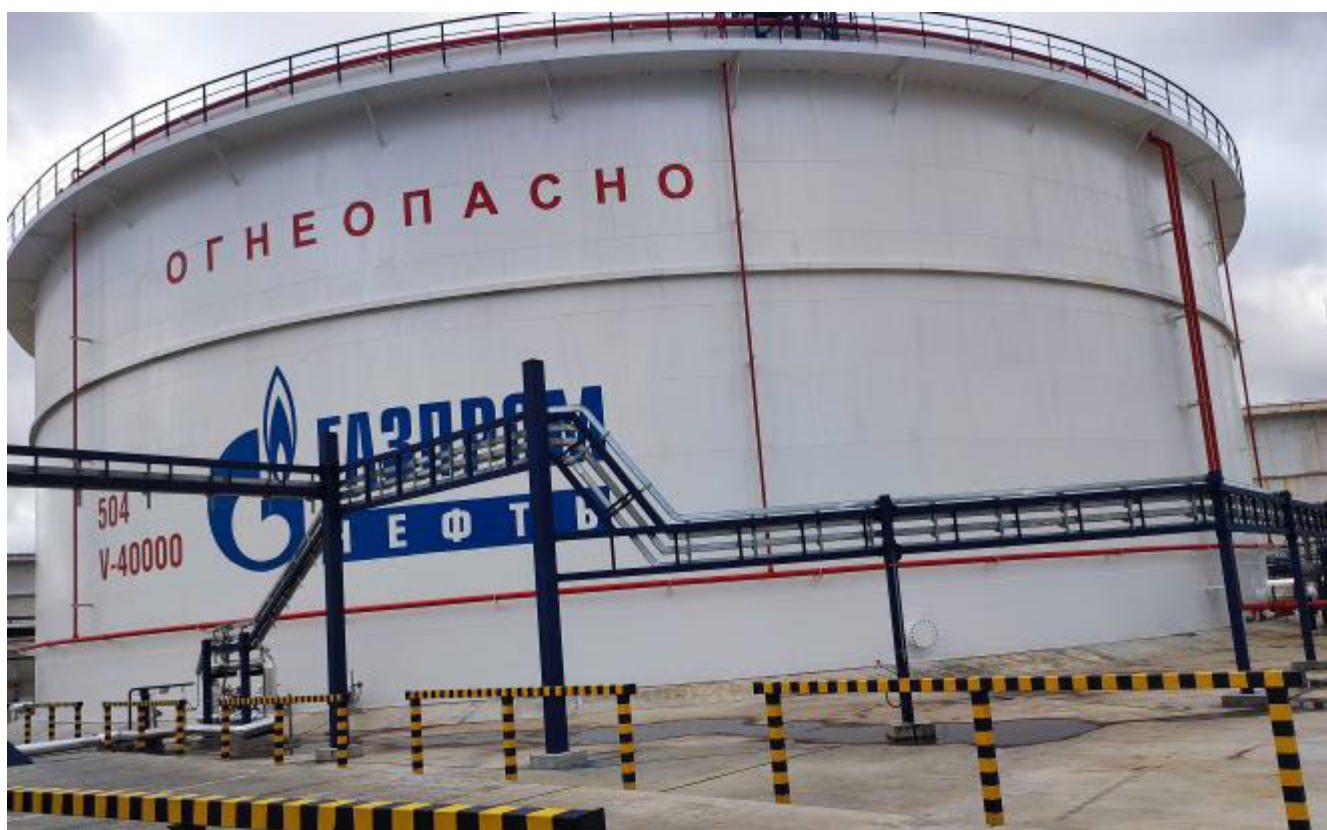
Рисунок 1 – Общий вид резервуара РВСПК-40000 №504
