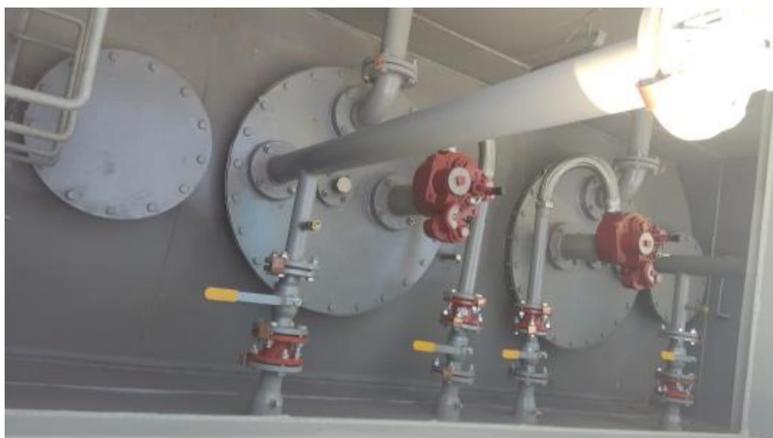
Рисунок 3 – Горловины и измерительные люки резервуара СРП (35+15) зав.№ 1195
