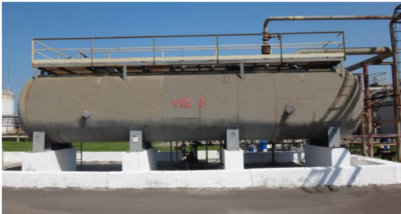
Рисунок 1 – Общий вид резервуара РГС-100
