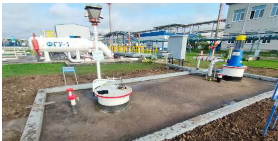
Рисунок 2 – Фотография горловины и крышки замерного люка резервуара
