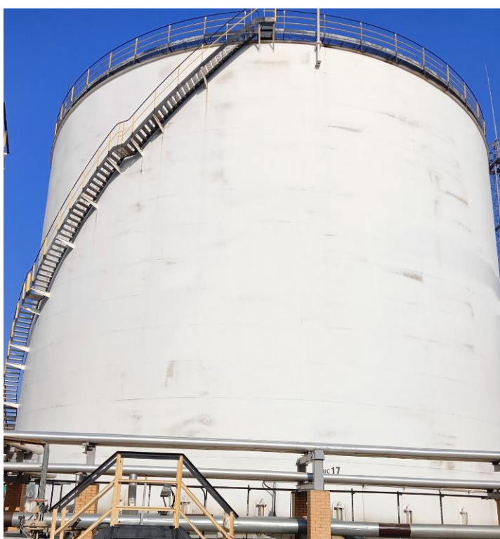
Рисунок 4 – Общий вид резервуара РВС-13300 № Р-17
