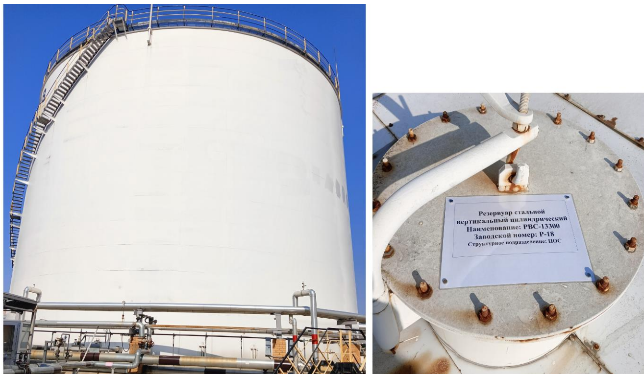
Рисунок 5 – Общий вид резервуара PBC-13300 № P-18 Пломбирование резервуаров PBC-13300 не предусмотрено.
