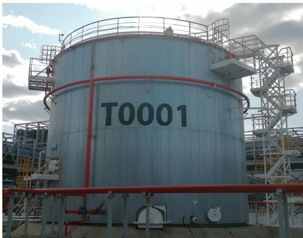
Рисунок 1 – Общий вид резервуара РВСП-2000 зав.№ Т0001
