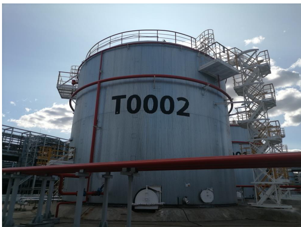
Рисунок 2 – Общий вид резервуара РВСП-2000 зав.№ Т0002
