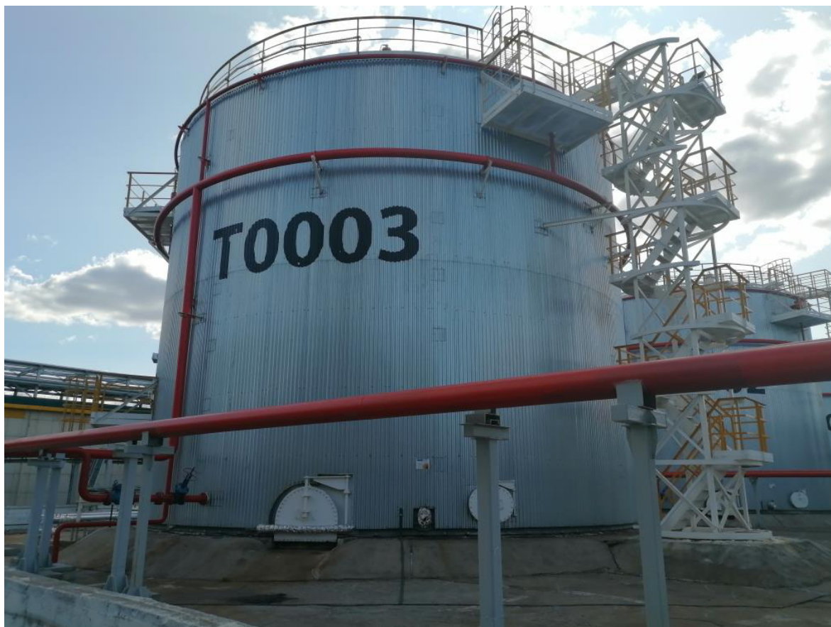
Рисунок 3 – Общий вид резервуара РВСП-2000 зав.№ Т0003 Пломбирование резервуаров РВСП-2000 не предусмотрено.
