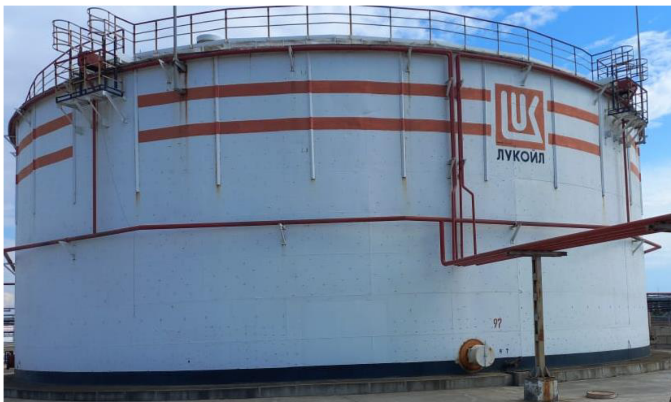
Рисунок 3 – Общий вид резервуара РВС-10000 №97
