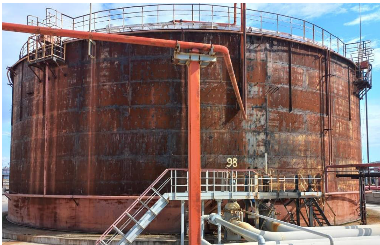
Рисунок 4 – Общий вид резервуара РВС-10000 №98
