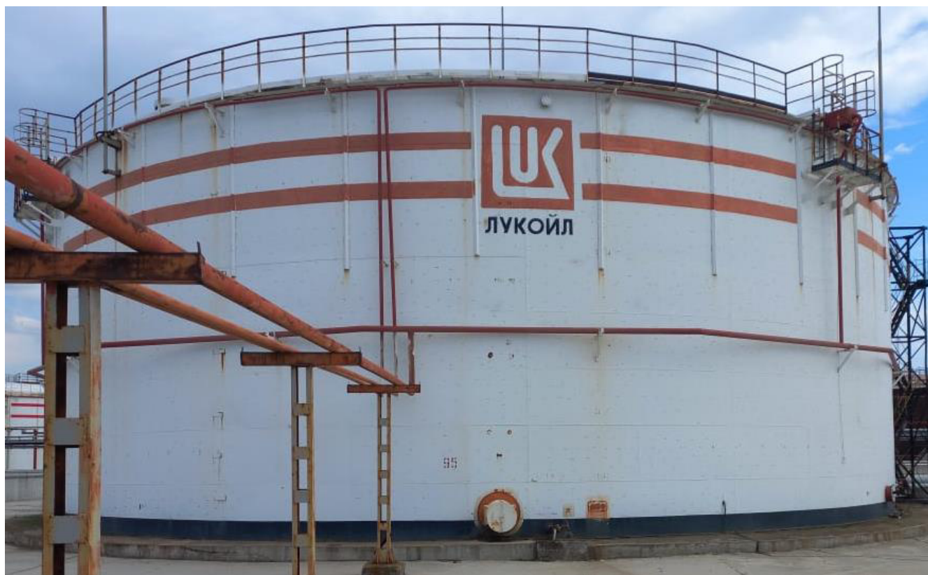
Рисунок 1 – Общий вид резервуара РВС-10000 №95
