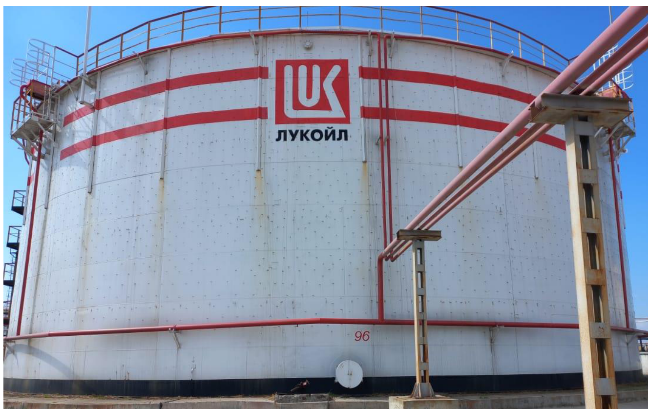
Рисунок 2 – Общий вид резервуара РВС-10000 №96
