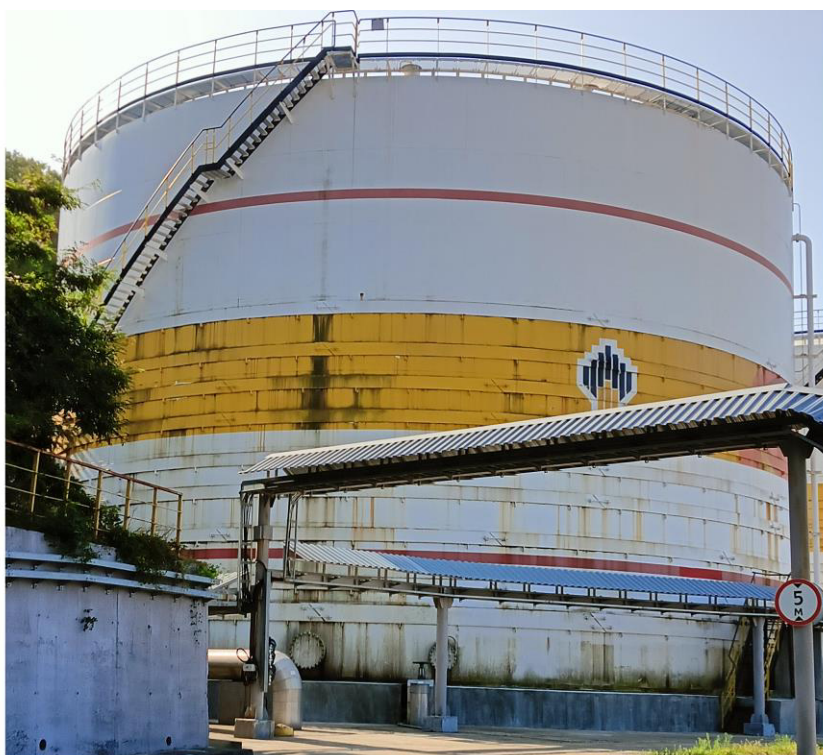
Рисунок 1 – Общий вид резервуара РВС-10000 № ЕВ-1
