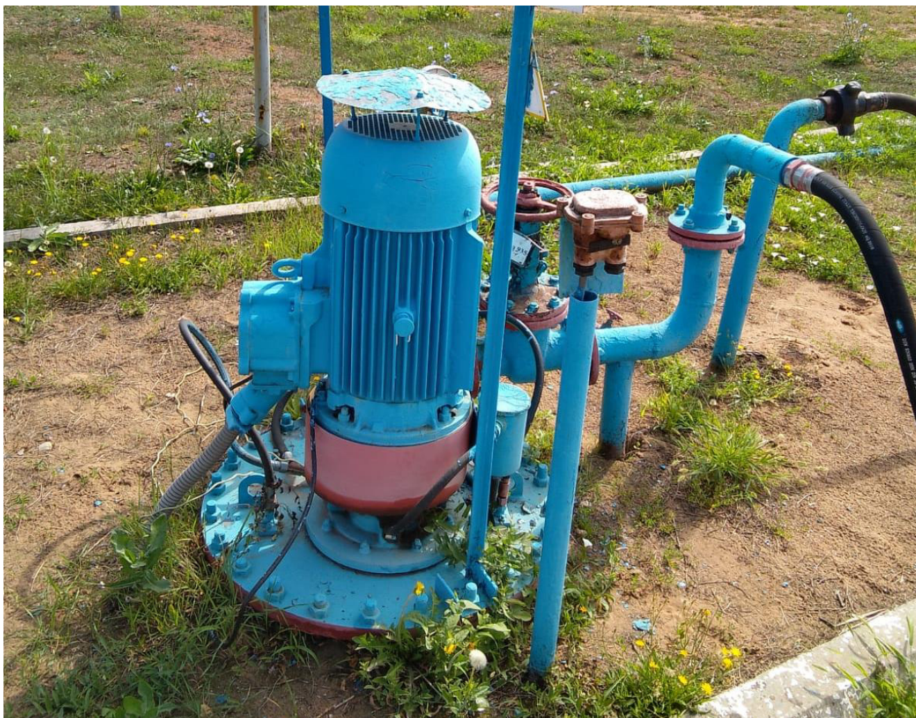
Рисунок 3 – Горловина резервуара РГС-16 зав.№ 345
