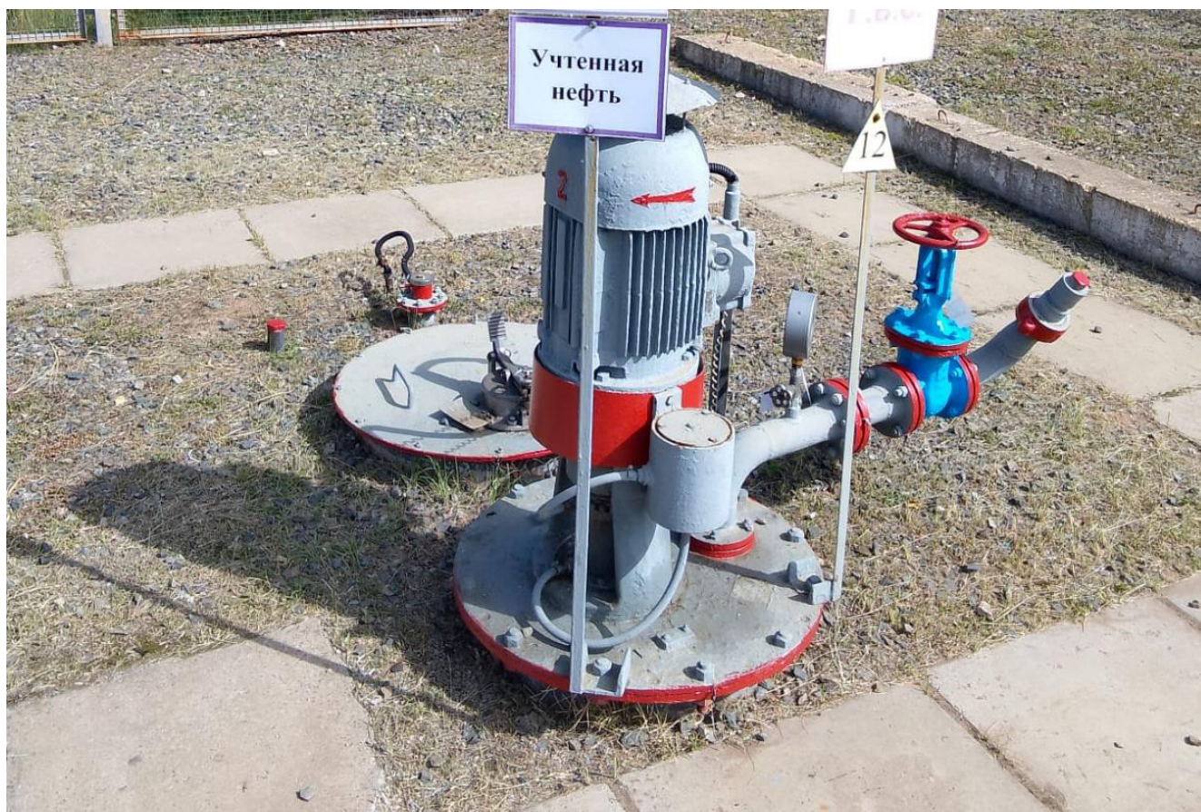
Рисунок 3 – Горловины и измерительный люк резервуара РГС-8 зав.№ 37
