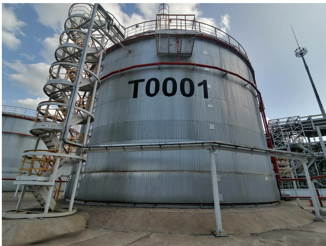
Рисунок 1 – Общий вид резервуара РВСП-3000 зав.№ Т0001
