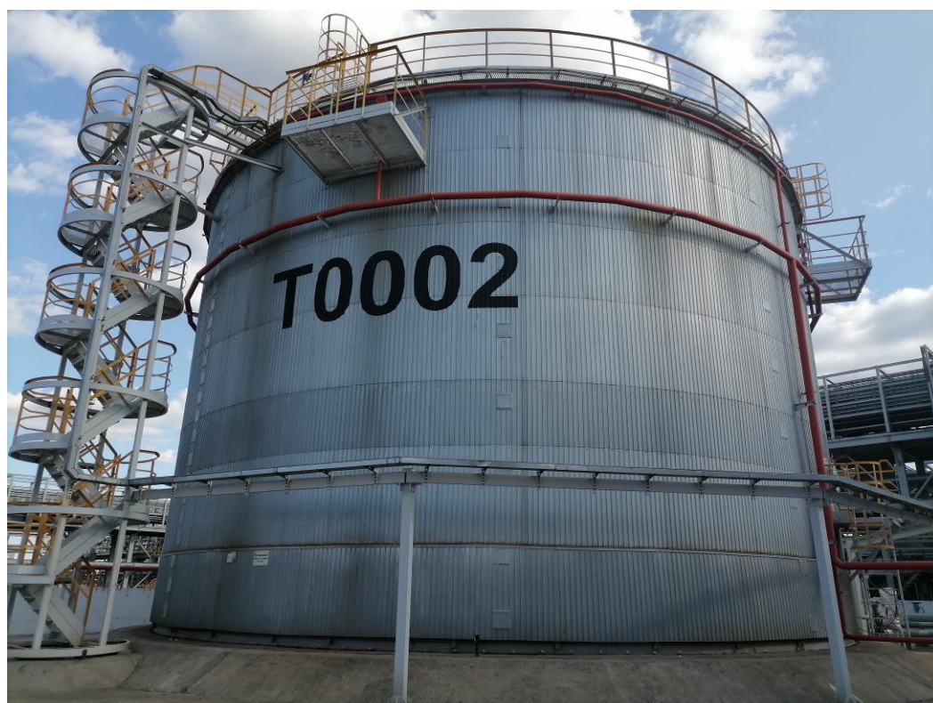
Рисунок 2 – Общий вид резервуара РВСП-3000 зав.№ Т0002
