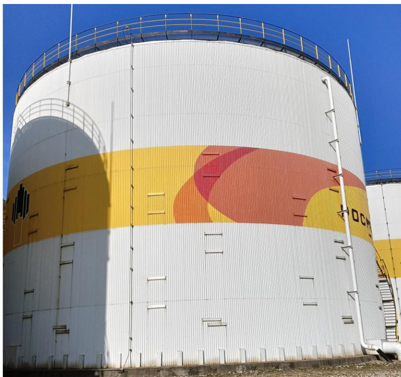
Рисунок 3 – Общий вид резервуара РВС-10000 № 701-РВС-10000/3
