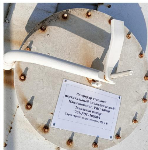
Рисунок 1 – Общий вид резервуара РВС-10000 № 701-РВС-10000/1
