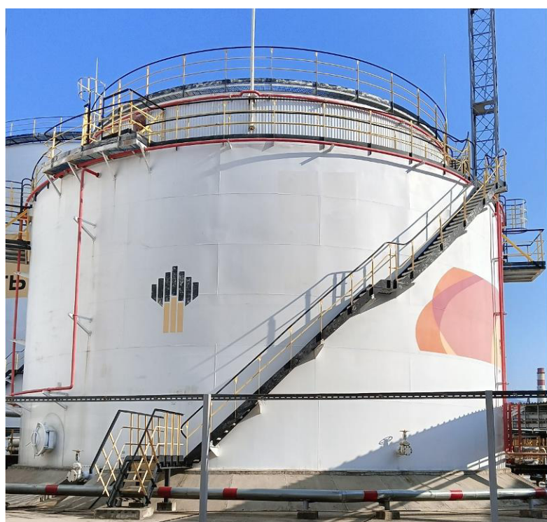
Рисунок 2 – Общий вид резервуара РВС-2000 № Р-20
