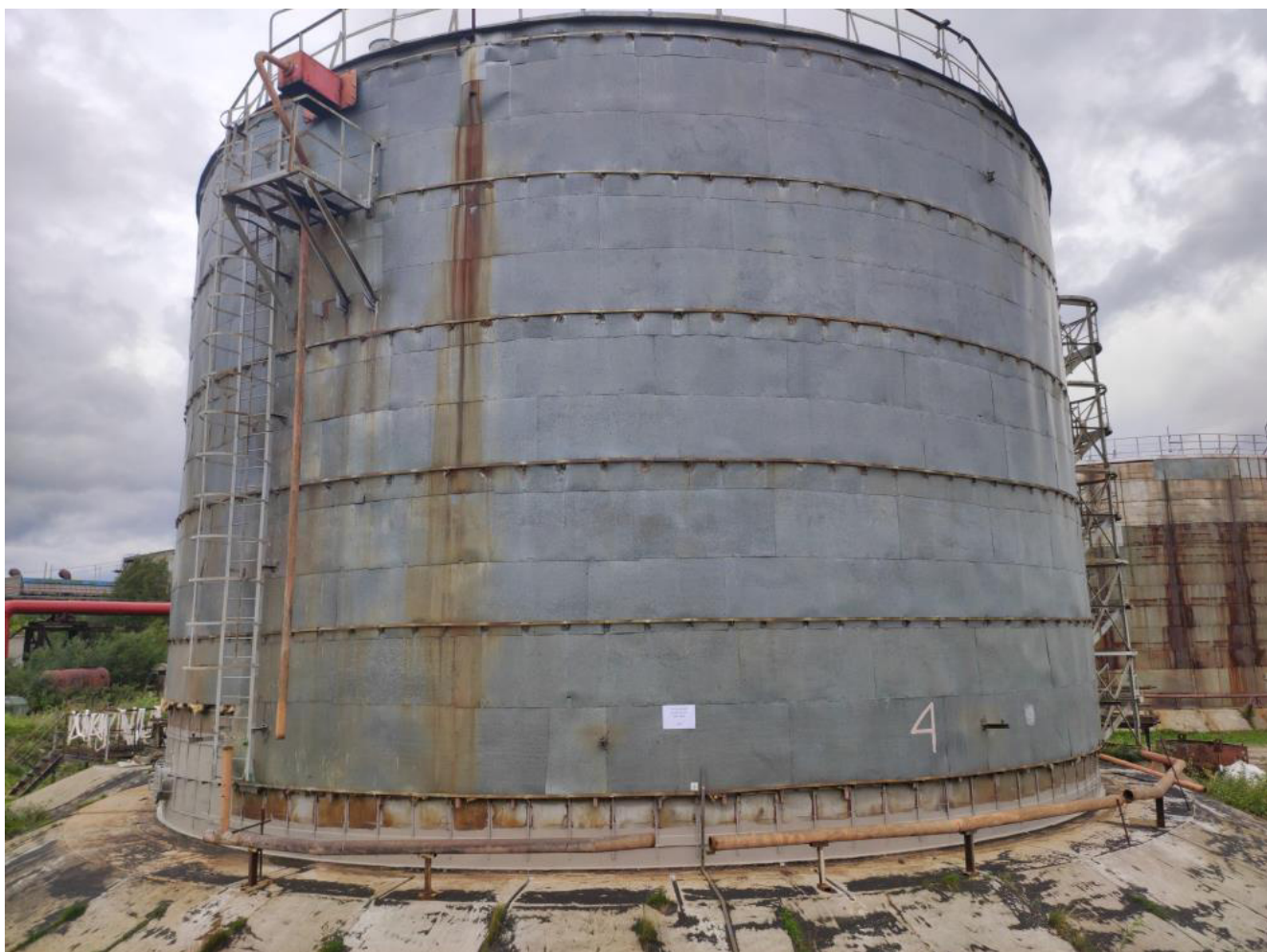
Рисунок 1 – Общий вид резервуара РВС-3000
