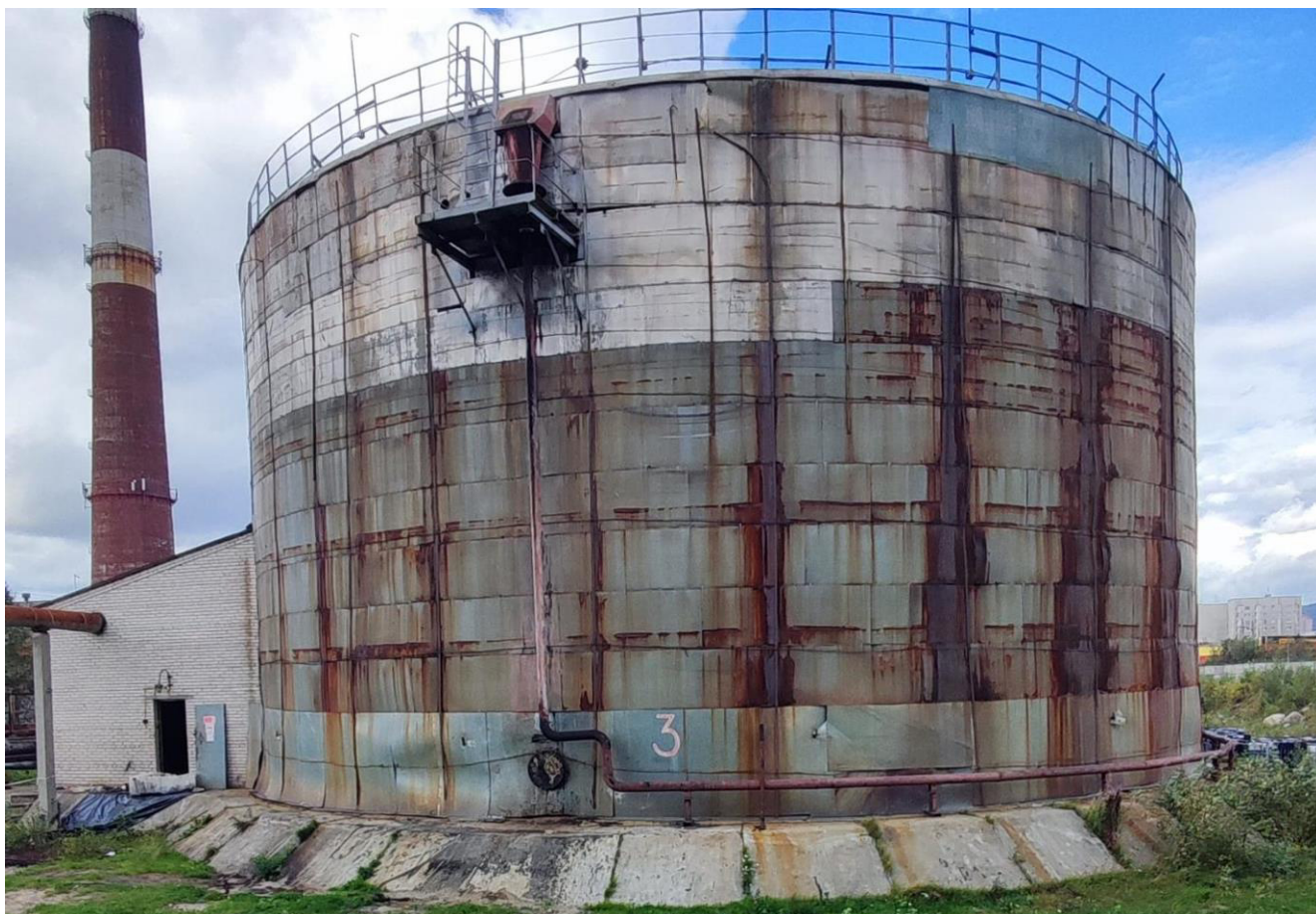
Рисунок 1 – Общий вид резервуара РВС-5000 Пломбирование резервуара РВС-5000 не предусмотрено.
