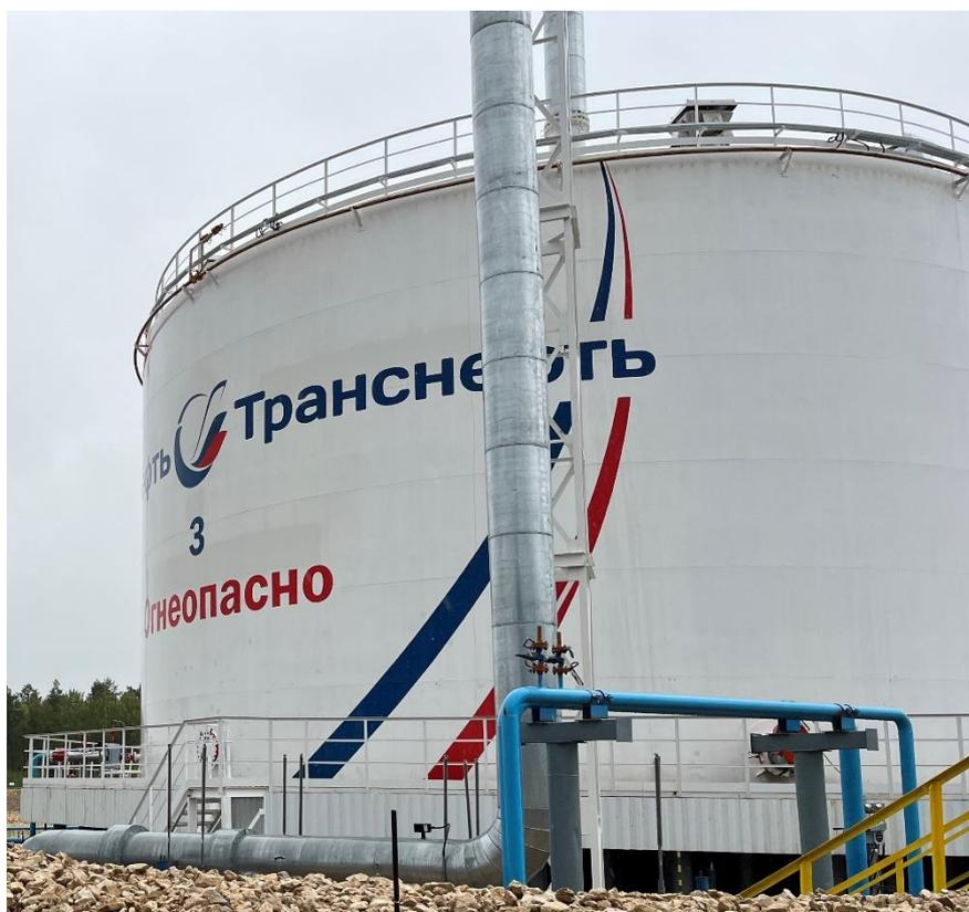
Рисунок 1 – Общий вид резервуара РВС-5000
