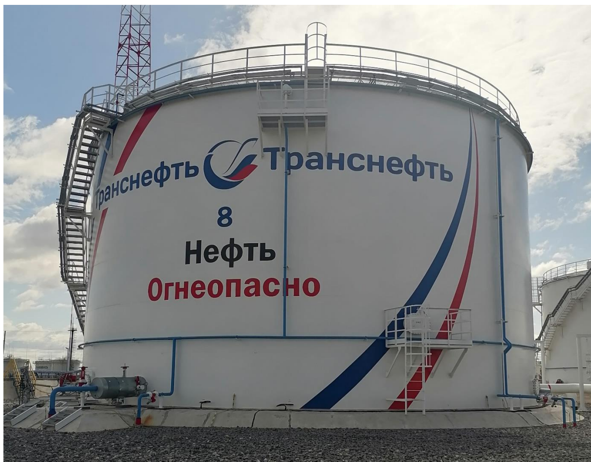
Рисунок 1 – Общий вид резервуара РВСП-5000
