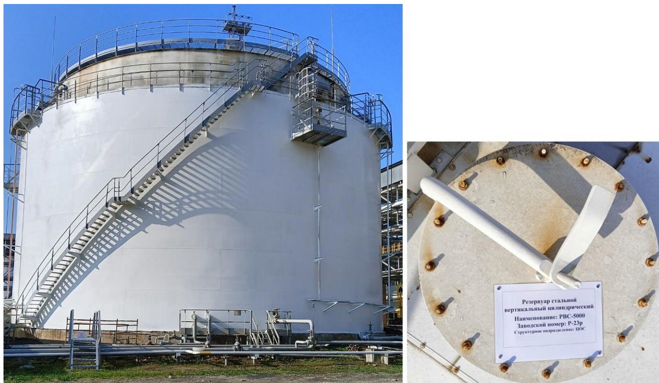
Рисунок 1 – Общий вид резервуара РВС-5000 № Р-23р
