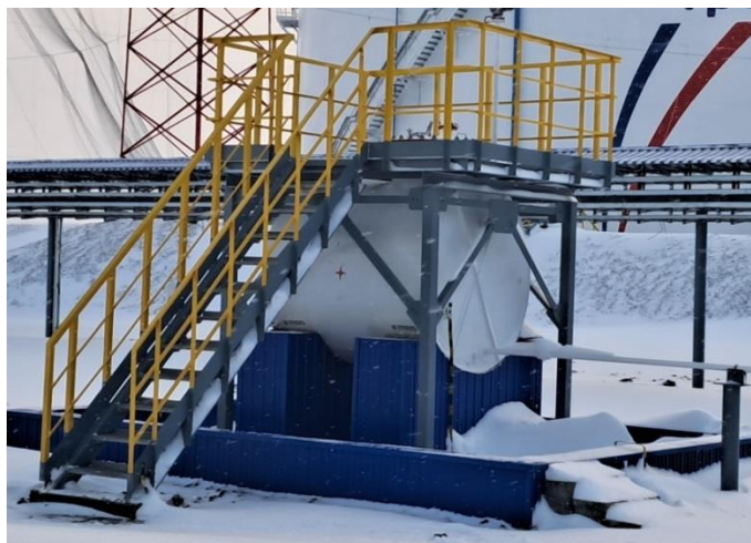
Рисунок 1 – Фотография общего вида резервуара стального горизонтального цилиндрического РГС-5, заводской номер 1/23
