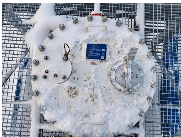
Рисунок 2 – Фотография горловины резервуара стального горизонтального цилиндрического РГС-5, заводской номер 1/23
