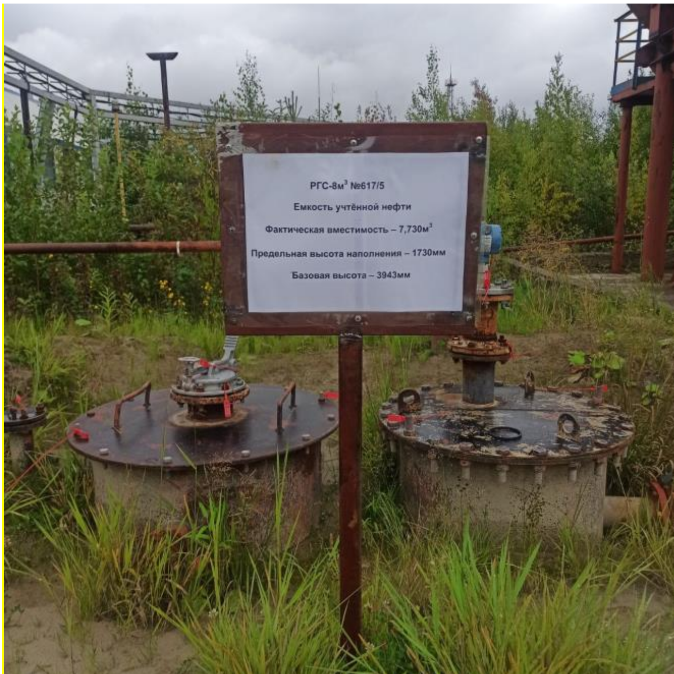
Рисунок 1 – Общий вид резервуара РГС-8
