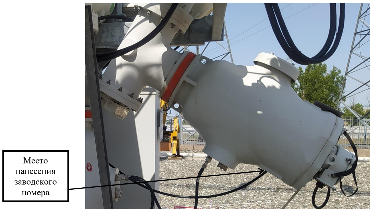
Рисунок 1 – Общий вид трансформатора напряжения TVBs123
