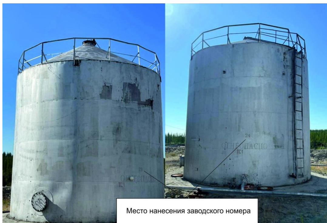
Рисунок 2 – Общий вид резервуаров вертикальных стальных цилиндрических РВС с указанием места нанесения заводских номеров
