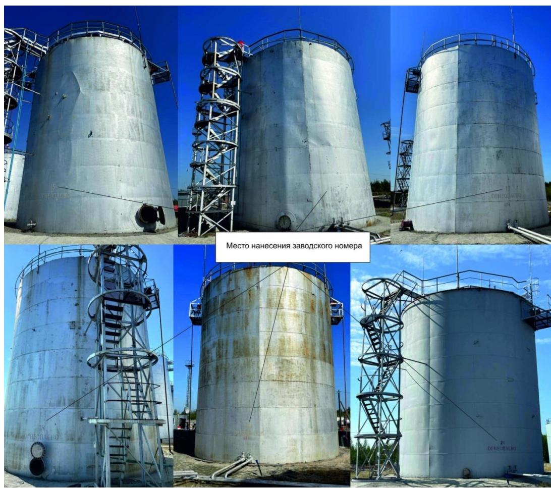
Рисунок 1 – Общий вид резервуаров вертикальных стальных цилиндрических РВС с указанием места нанесения заводских номеров
