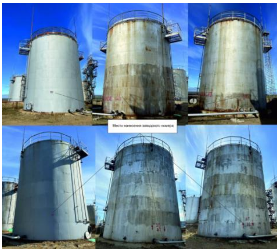
Рисунок 3 – Общий вид резервуаров вертикальных стальных цилиндрических РВС с указанием места нанесения заводских номеров
