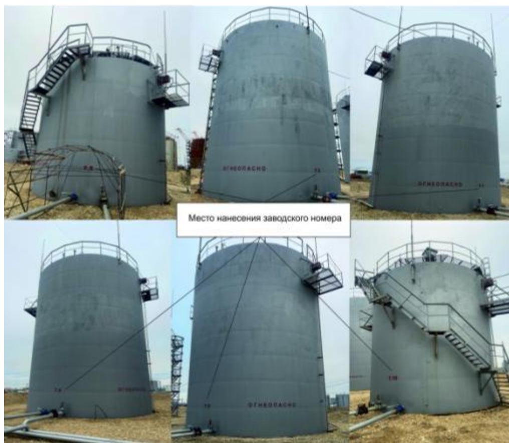
Рисунок 8 – Общий вид резервуаров вертикальных стальных цилиндрических РВС с указанием места нанесения заводских номеров
