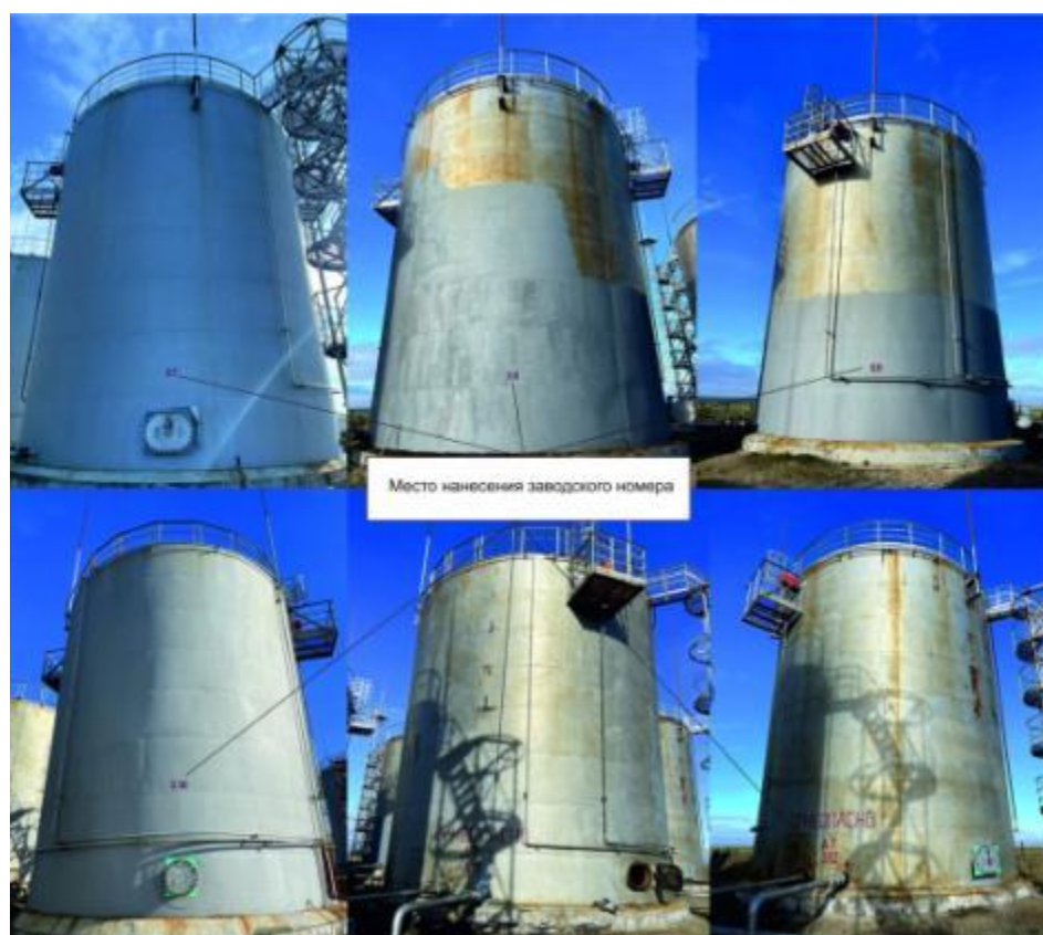
Рисунок 4 – Общий вид резервуаров вертикальных стальных цилиндрических РВС с указанием места нанесения заводских номеров
