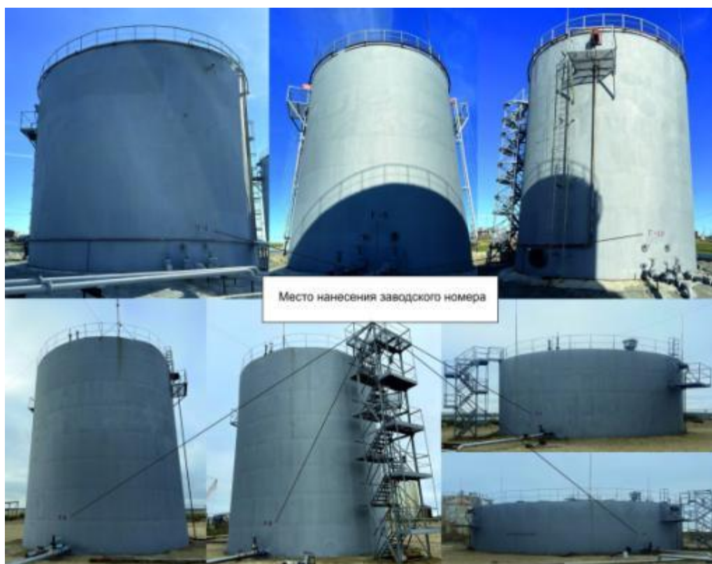
Рисунок 7 – Общий вид резервуаров вертикальных стальных цилиндрических РВС с указанием места нанесения заводских номеров
