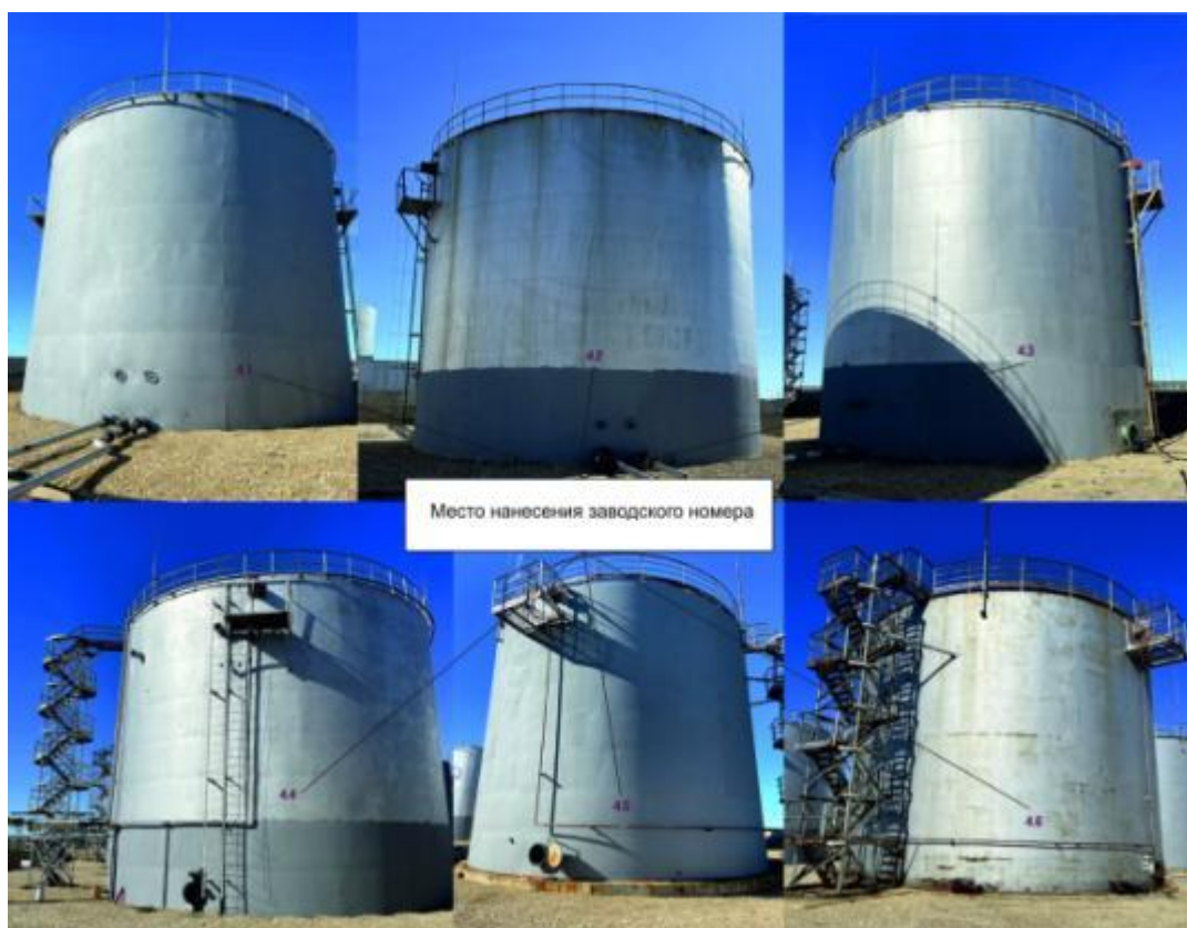
Рисунок 5 – Общий вид резервуаров вертикальных стальных цилиндрических РВС с указанием места нанесения заводских номеров
