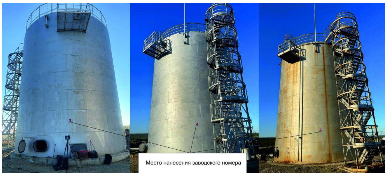
Рисунок 1 – Общий вид резервуаров вертикальных стальных цилиндрических РВС-1000 с указанием места нанесения заводских номеров
