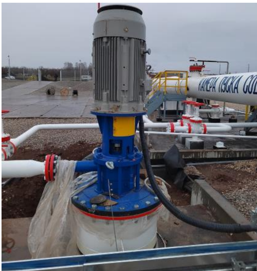
Рисунок 3 – Горловина резервуара ЕП-40-550-А-СО-У1 зав.№ 59347
