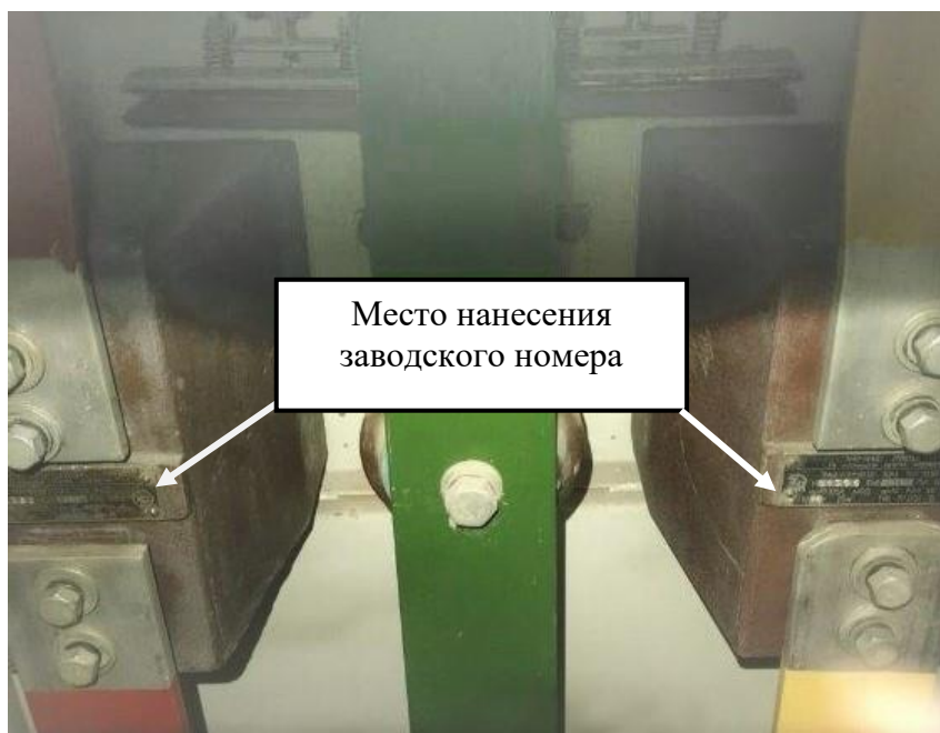
Рисунок 1 - Общий вид трансформаторов тока ТОЛ 10 У3 с указанием места нанесения заводского номера
