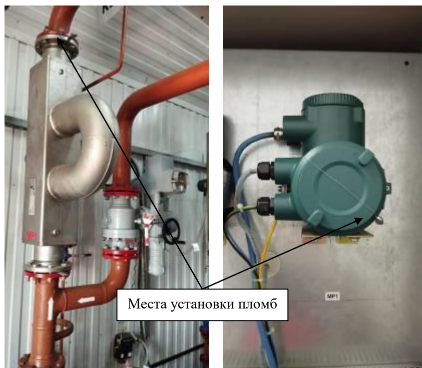
Рисунок 2 – Схема пломбировки от несанкционированного доступа
