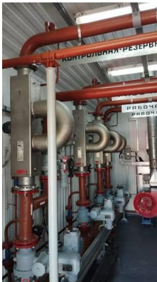
Рисунок 1 – Общий вид счетчика-расходомера
