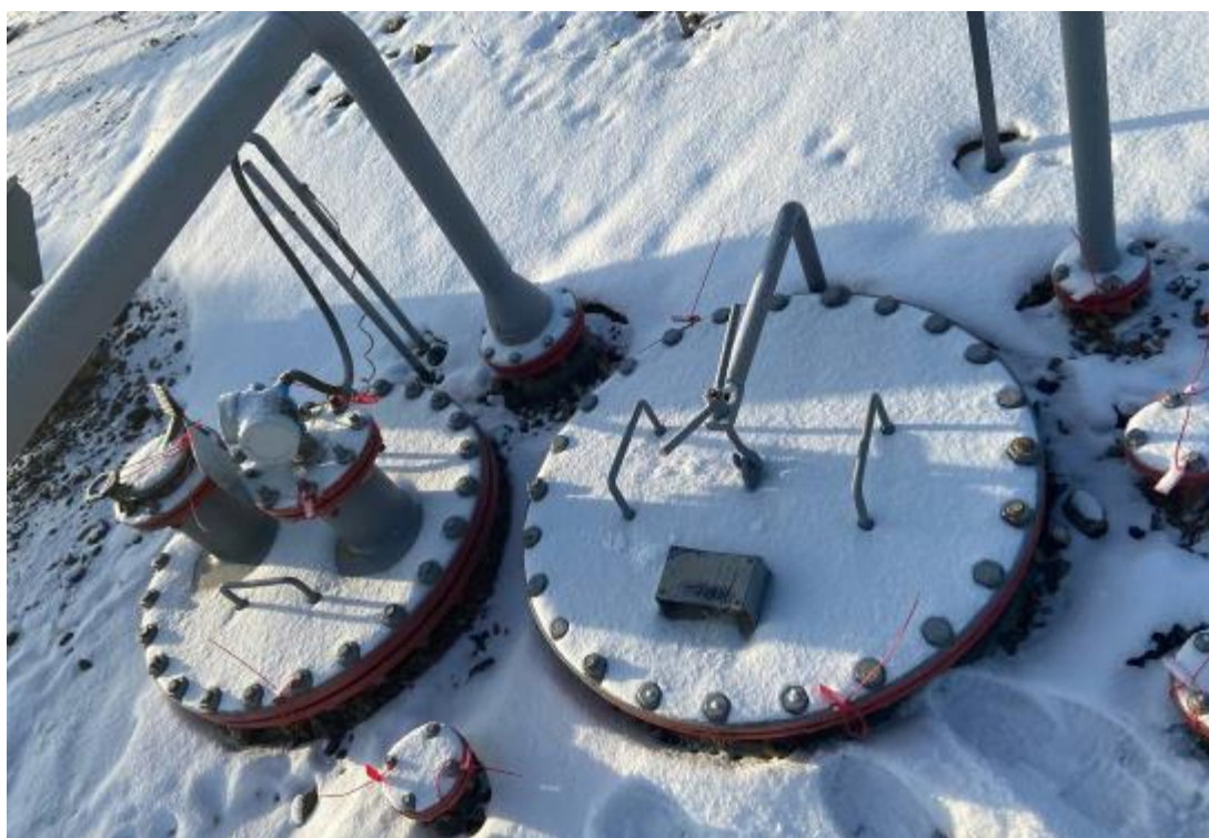
Рисунок 2 – Горловины резервуара ЕП-5 зав.№3400
