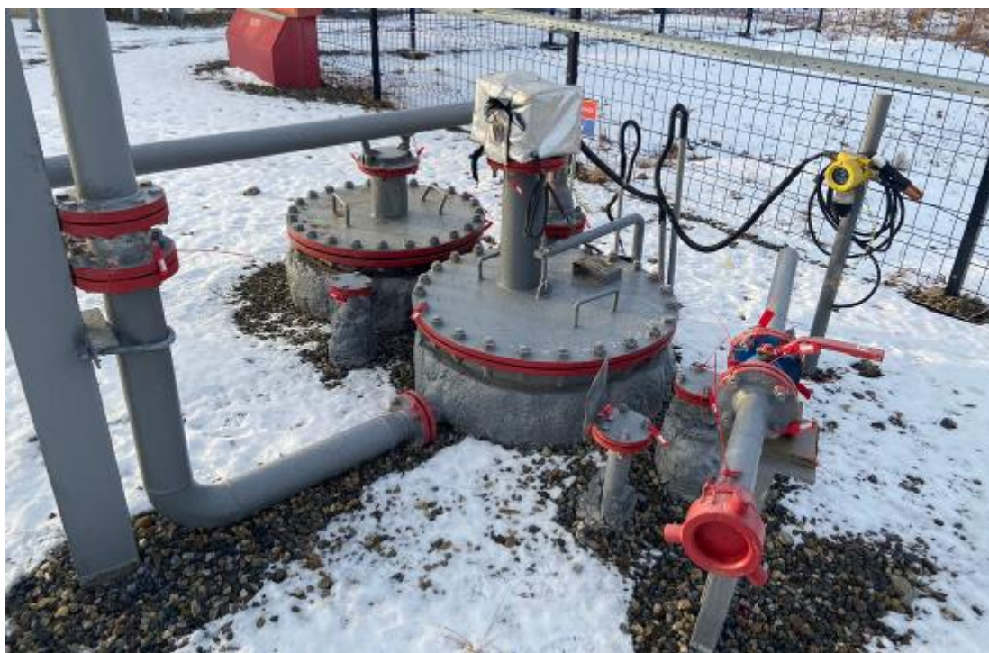
Рисунок 3 – Горловины резервуара ЕП-5 зав.№3403
