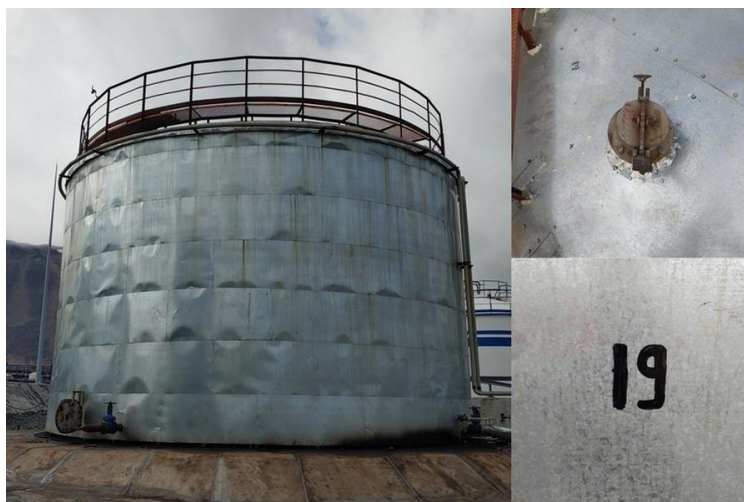
Рисунок 1 – Фотография общего вида резервуара стального вертикального цилиндрического РВС- 700, горловины замерного люка и заводского номера
