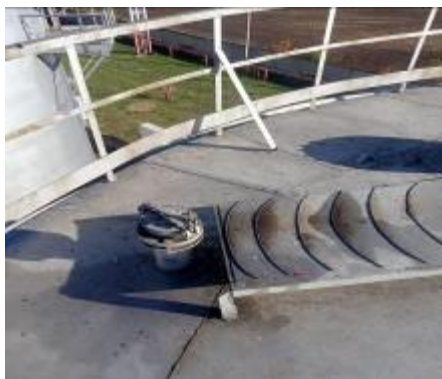
Рисунок 1 - Фотография горловины замерных люков резервуаров РВСП-1000
