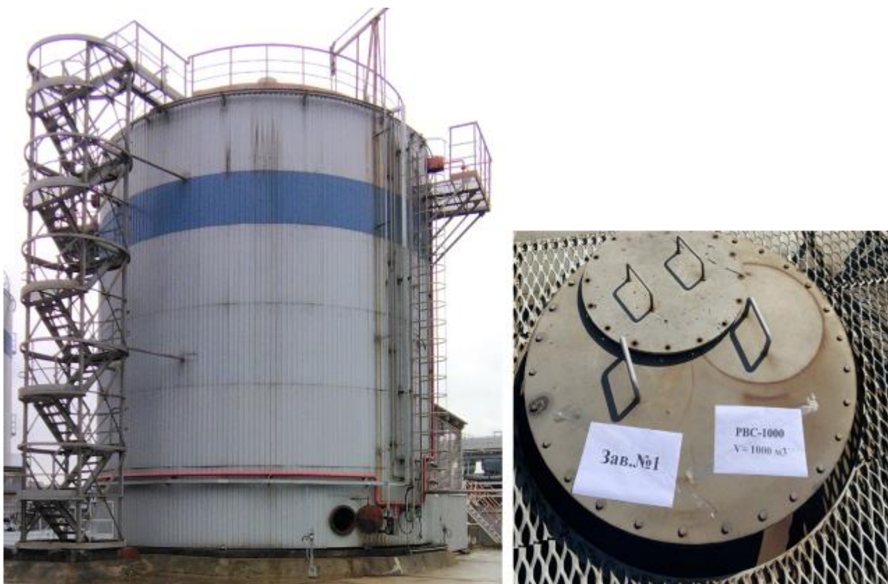
Рисунок 1 – Общий вид резервуара PBC-1000 № 1
