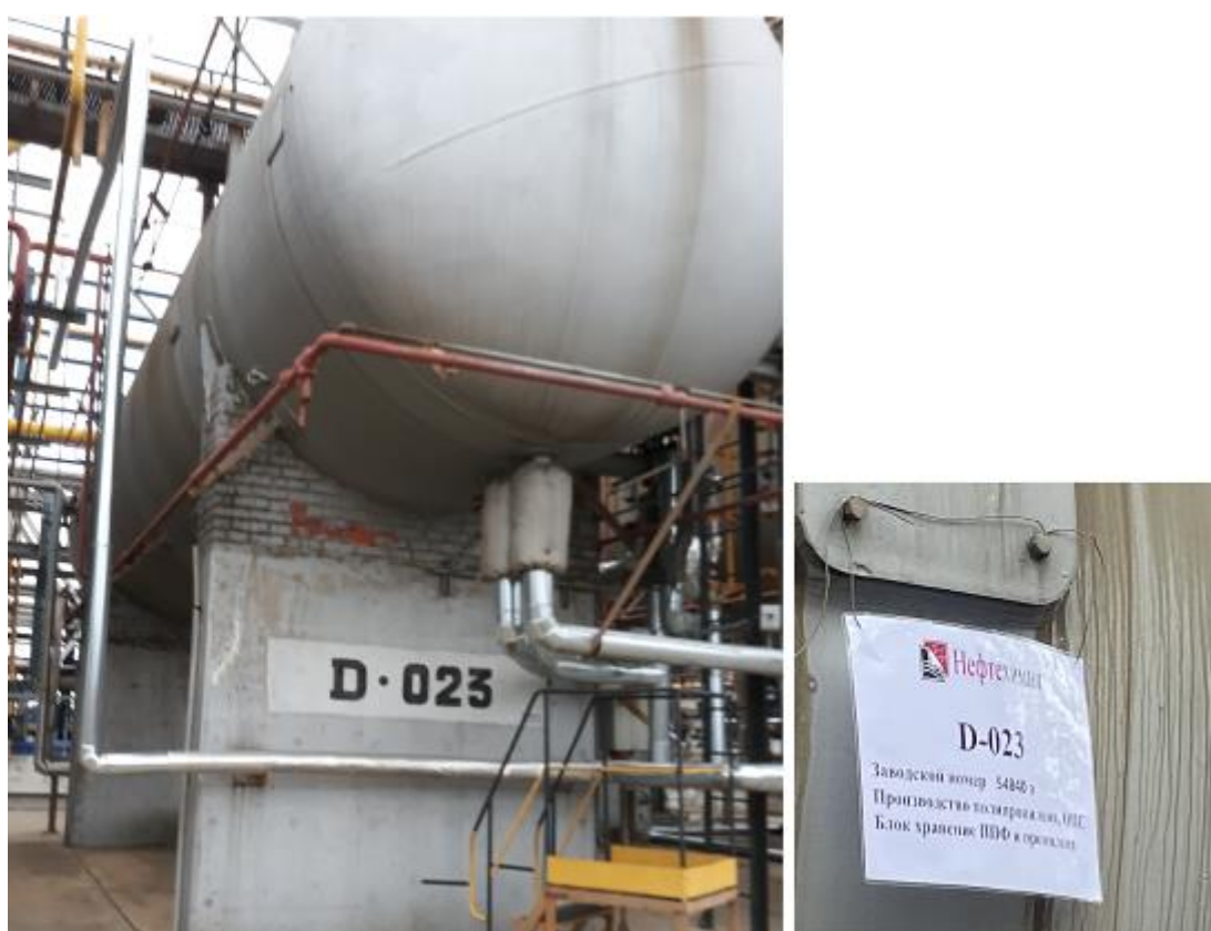
Рисунок 6 – Общий вид резервуара РГС-100 зав.№ 54840 э Пломбирование резервуаров РГС-100 не предусмотрено.
