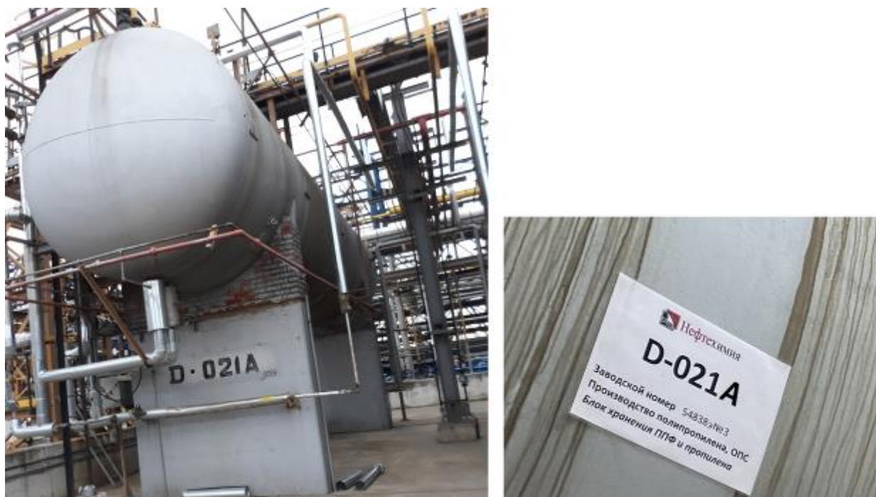
Рисунок 3 – Общий вид резервуара РГС-100 зав.№ 54838 э№3
