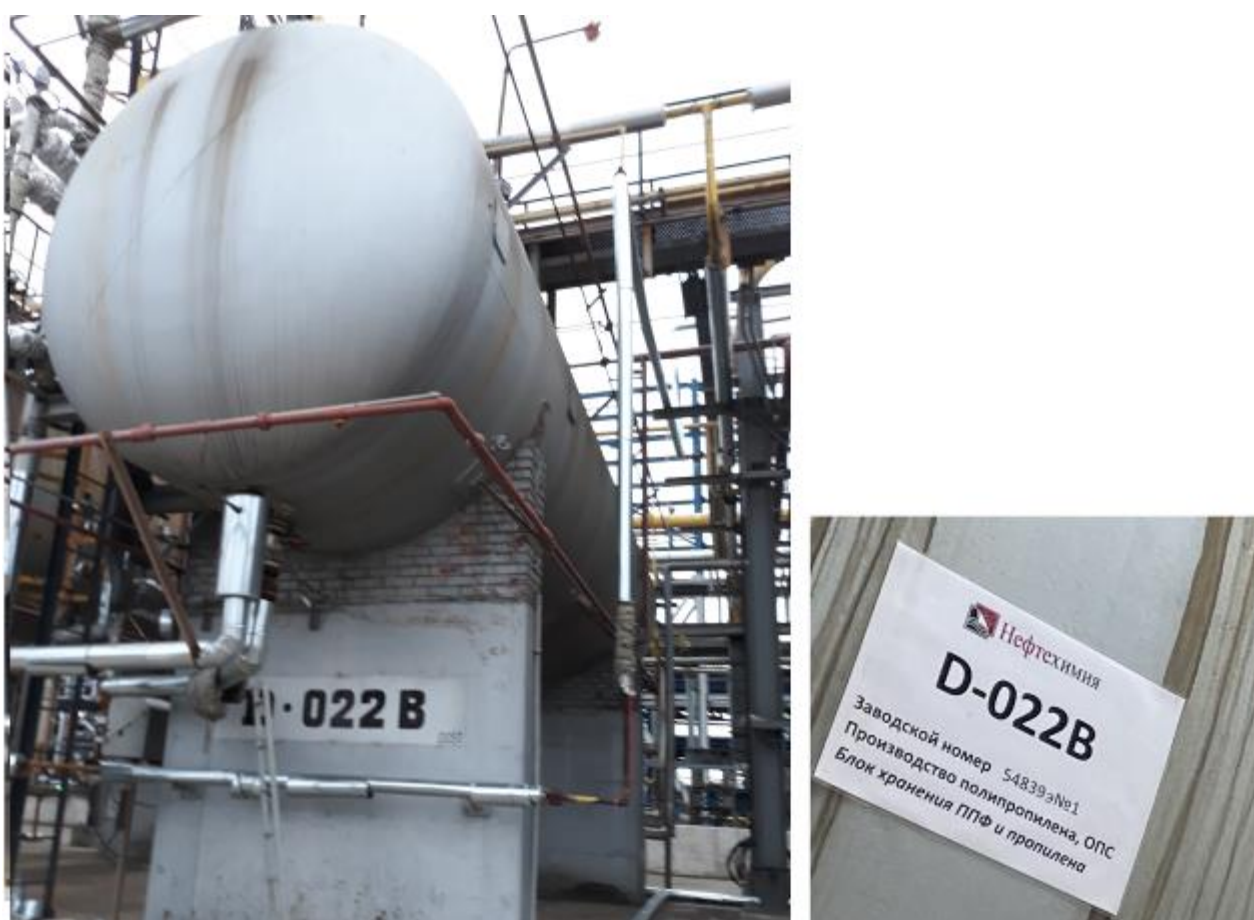
Рисунок 4 – Общий вид резервуара РГС-100 зав.№ 54839 э№1
