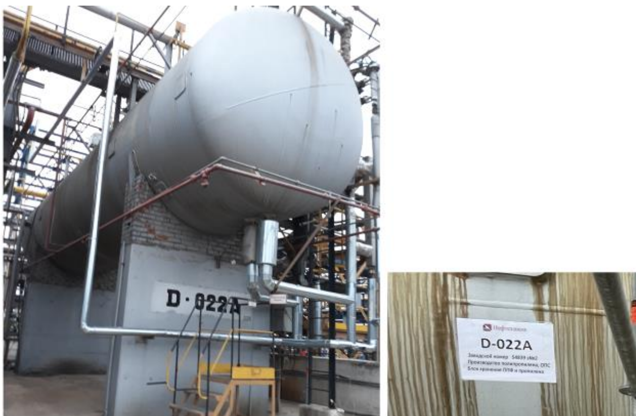
Рисунок 5 – Общий вид резервуара РГС-100 зав.№ 54839 э№2
