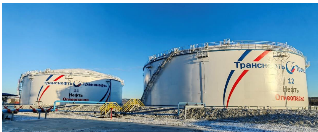
Рисунок 1 – Общий вид резервуаров РВСП-50000
