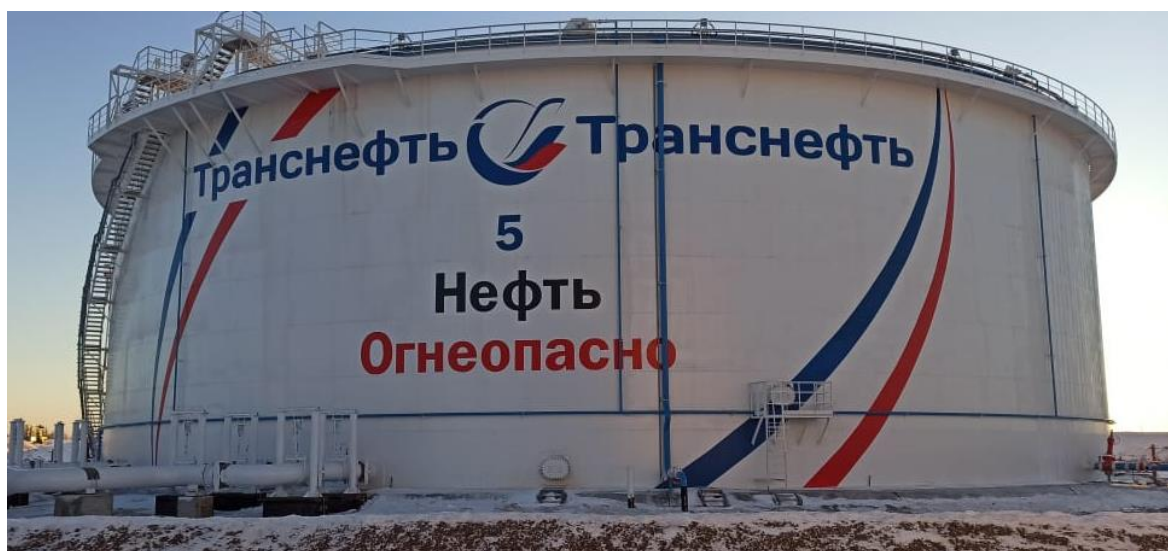
Рисунок 1 – Общий вид резервуара (заводской №5)
