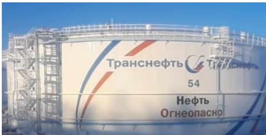
Рисунок 1 – Общий вид резервуара РВСП-20000 № 54
