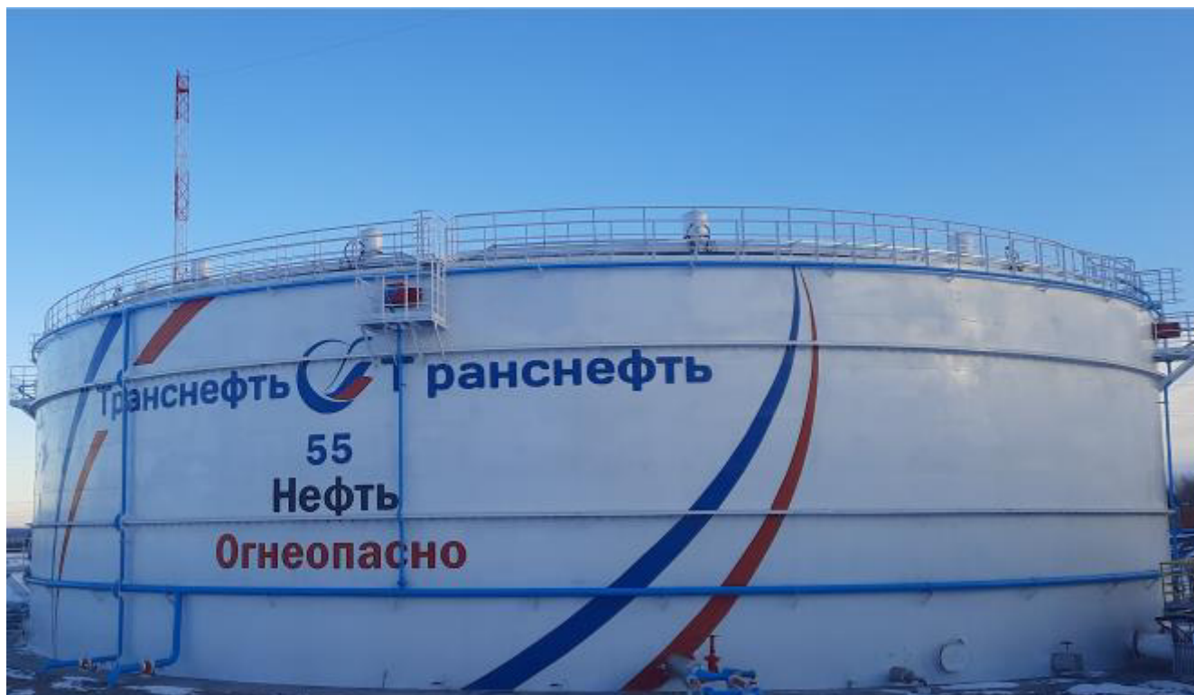
Рисунок 2 – Общий вид резервуара РВСП-20000 № 55
