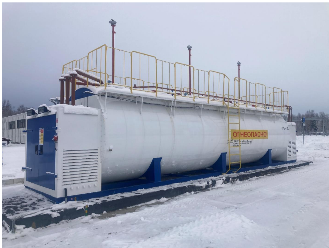
Рисунок 2 – Общий вид резервуара РГСД-60(20+20+20) с заводским номером 19052рД
