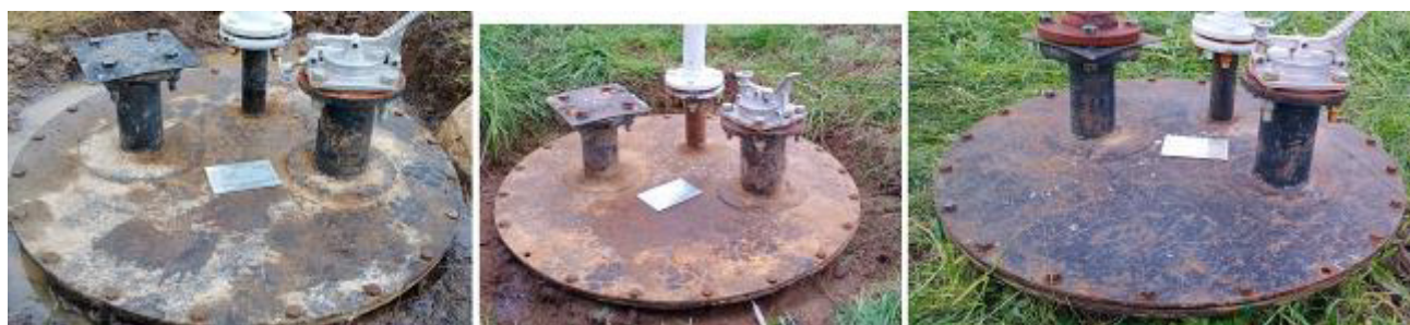
Рисунок 5 – Горловины и измерительные люки резервуаров РГСП-10
