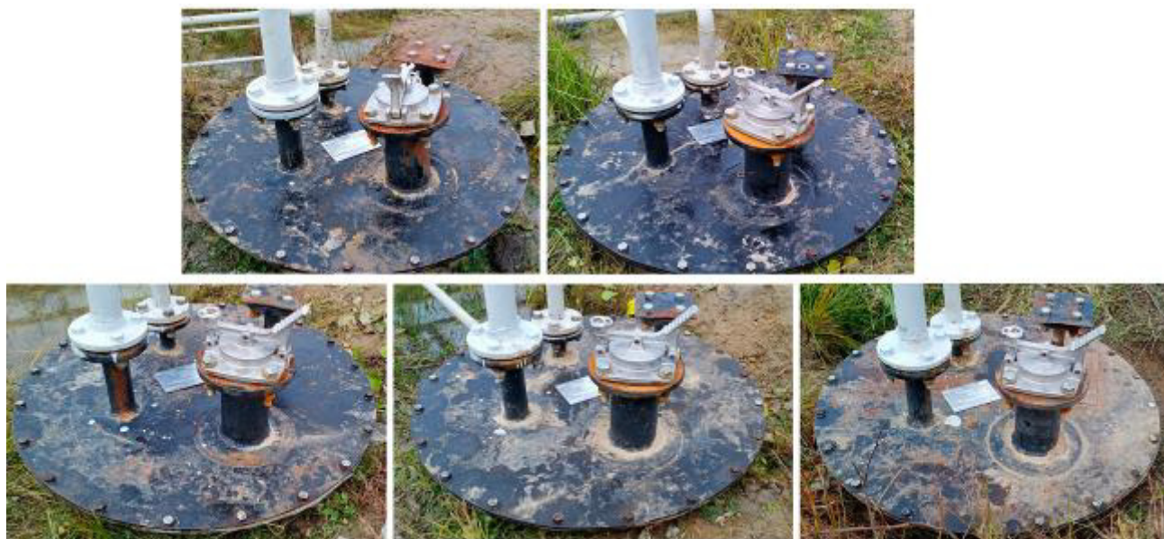
Рисунок 4 – Горловины и измерительные люки резервуаров РГСП-4
