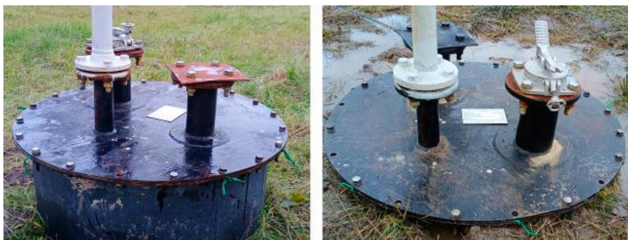
Рисунок 6 – Горловины и измерительные люки резервуаров РГСП-50
