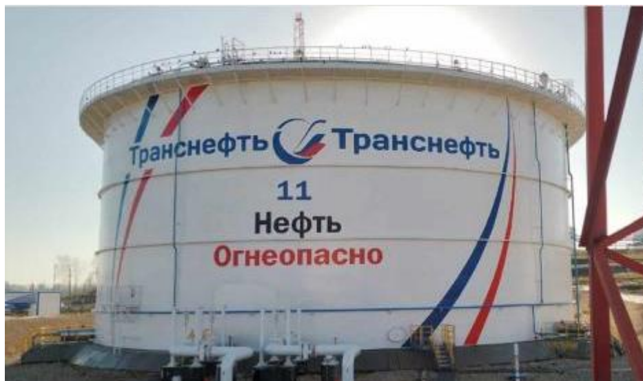
Рисунок 1 – Общий вид резервуара
