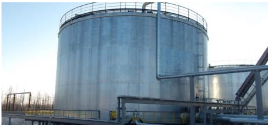
Рисунок 1 - Общий вид резервуаров.
